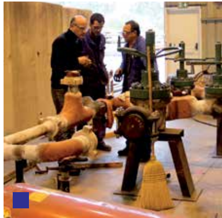
THIERRY VAUZOU, à gauche sur la photo, devant un module en cours de finition.
