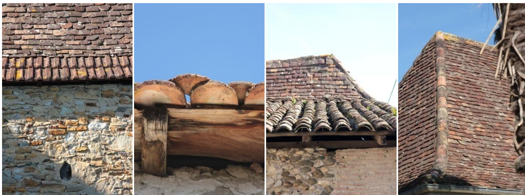
Faîtages et arêtières en tuiles rondes
