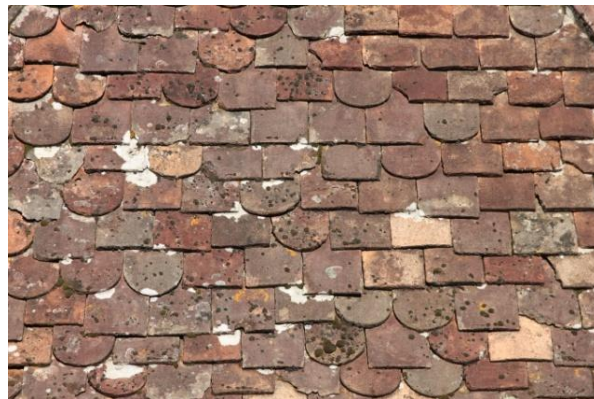
Tuiles plates arrondies mélangées à des rectangulaires
