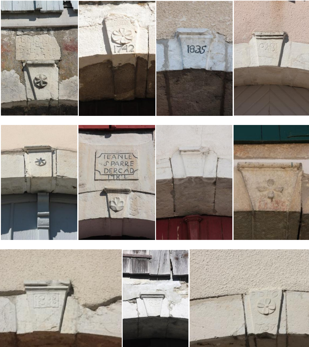
Les linteaux décorés et les clés datées participent à l'architecture traditionnelle béarnaise
