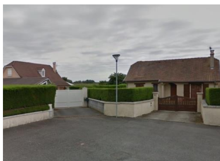
Constructions récentes en lotissement, habitat pavillonnaire de plain-pied
