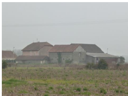
Bâtisses traditionnelle appartenant à un corps de ferme traditionnelle
