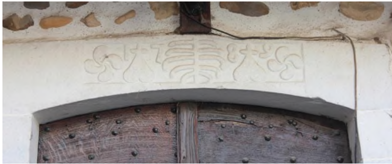
La porte de la grange, comme tout lieu de passage, comporte un encadrement soigné.
