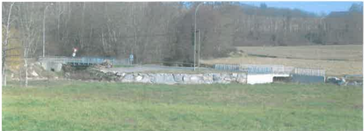
Aire de captage sur le Laà pour la défense incendie entre la mairie et la salle polyvalente
