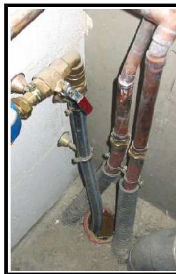
Calfeutrage des entrées de réseaux
