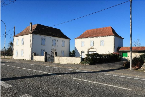
Figure 3 - Vue sur la « Maison Mattali » (parcelle AD15)
