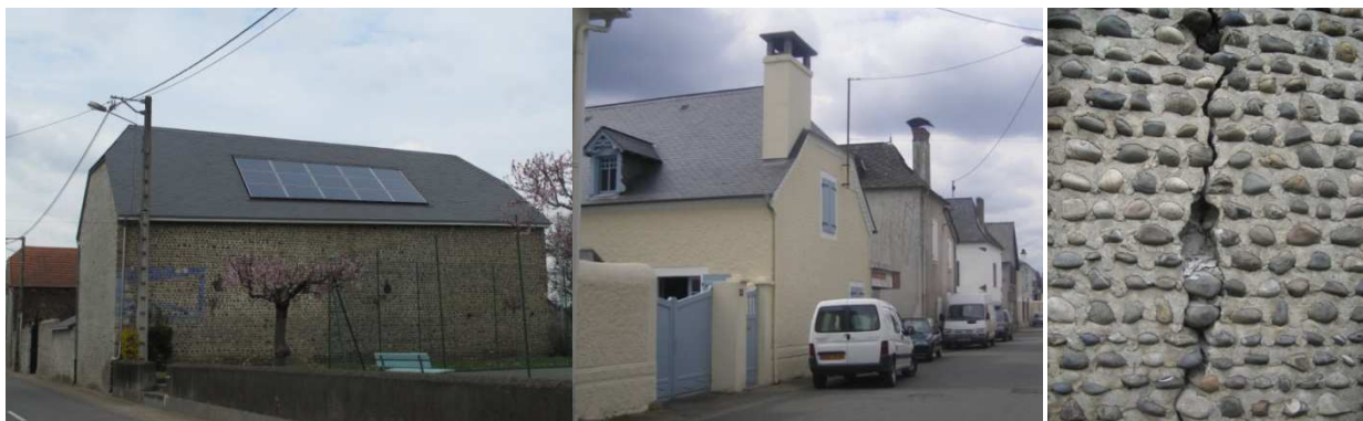
Exemples de réhabilitations (photos 1 et 2) et construction dégradée à réhabiliter (photo 3)
