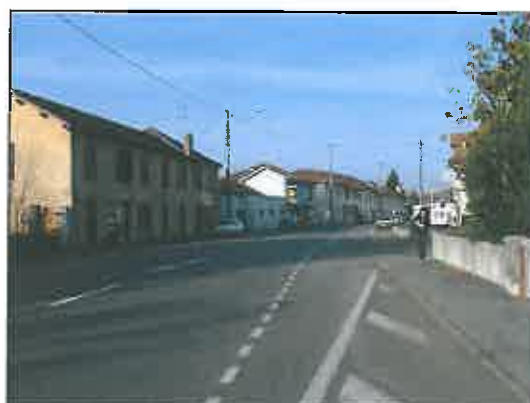
Un bâti mitoyen le long de la RN117
