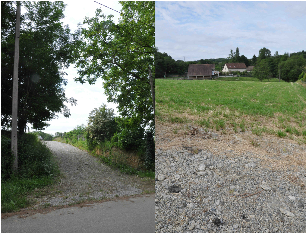
Accès réalisé. Poteau électrique n°1 installé pour alimenter les deux lots.
