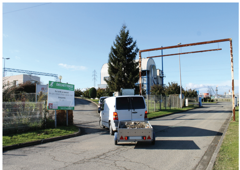
La déchetterie de Mourenx a été construite en 1992. Soit deux années après l'usine d'incinération d'ordures ménagères (au second plan sur la photo) qui fut le premier équipement de ce type en activité dans le département.
