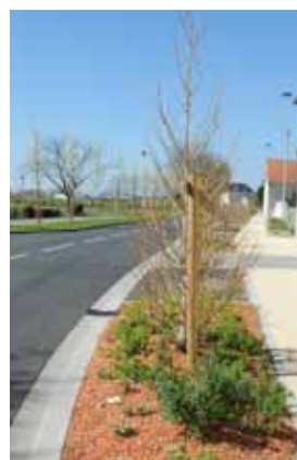
OS-MARSILLON travaux terminés de réaménagement du centre bourg
