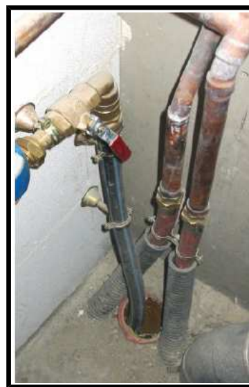
Calfeutrage des entrées de réseaux
