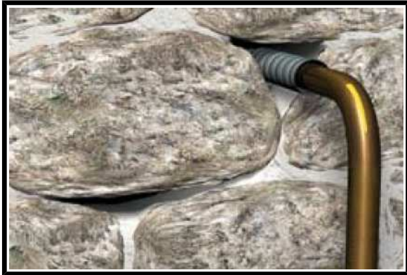
Situation initiale avant colmatage
