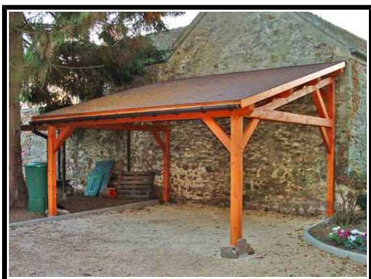
Construction annexe adossée
