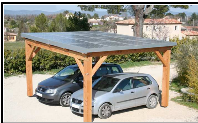
Construction annexe non contiguë
