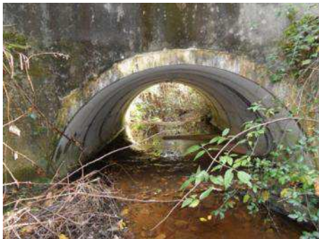
Exemple d'ouvrage hydraulique ne disposant pas de passage à sec pour le déplacement de la petite faune terrestre
