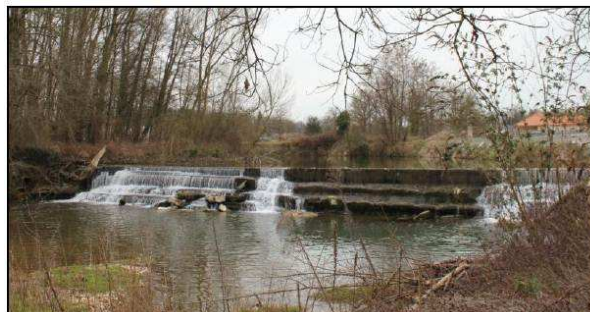
Figure 30 : Seuil en aval de la Bayse (Source : GEOCIAM)
