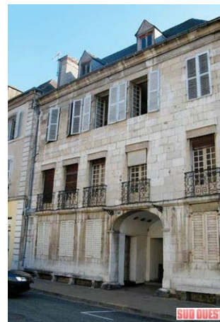
Exemple de logement insalubre : Hôtel de La Belle Hôtesse
