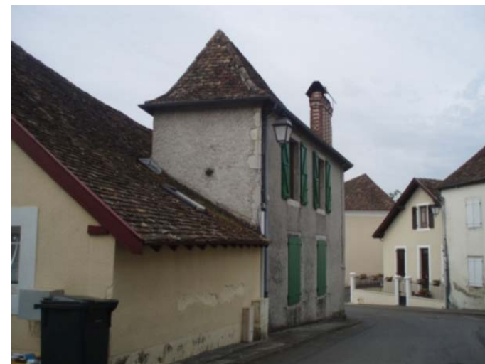
Rues en centre bourg
