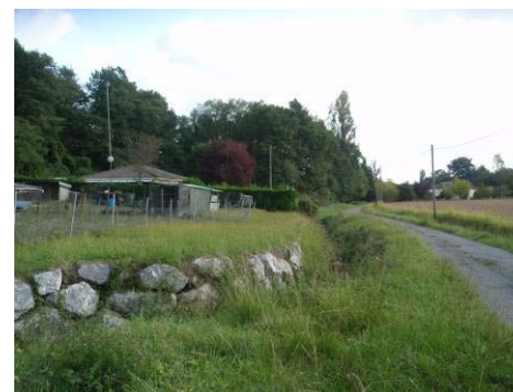
Enrochement, absence de ripisylve
