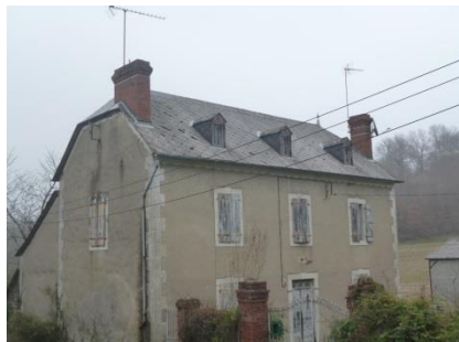
Bâtiment traditionnel du centre bourg en R+1+combles
