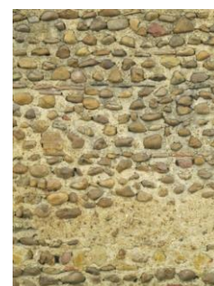
Murs en galets, symboles des bâtiments de stockage agricoles, mais usités pour les habitations
