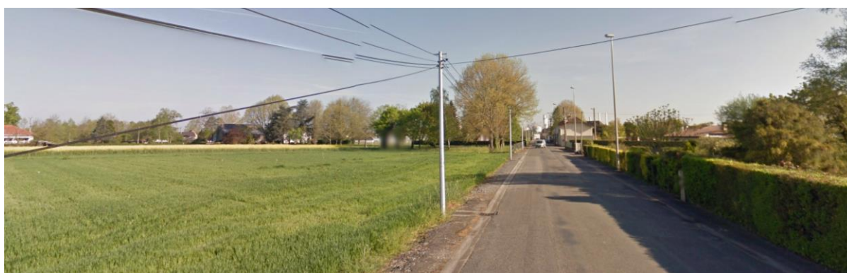
Rue des Pyrénées (RD 333) délimitant à l'Est la zone 1AU i sur 130 m (Source : Google Maps)
