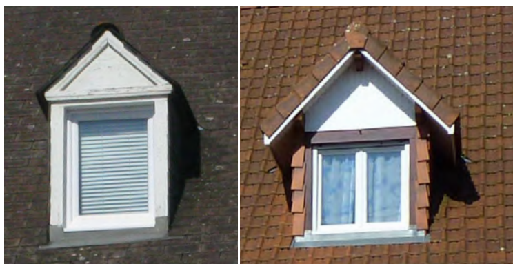
En Toiture, lucarnes à 2 pans dites Jacobines
