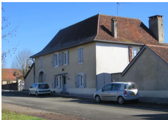
Constructions anciennes dans la bastide
