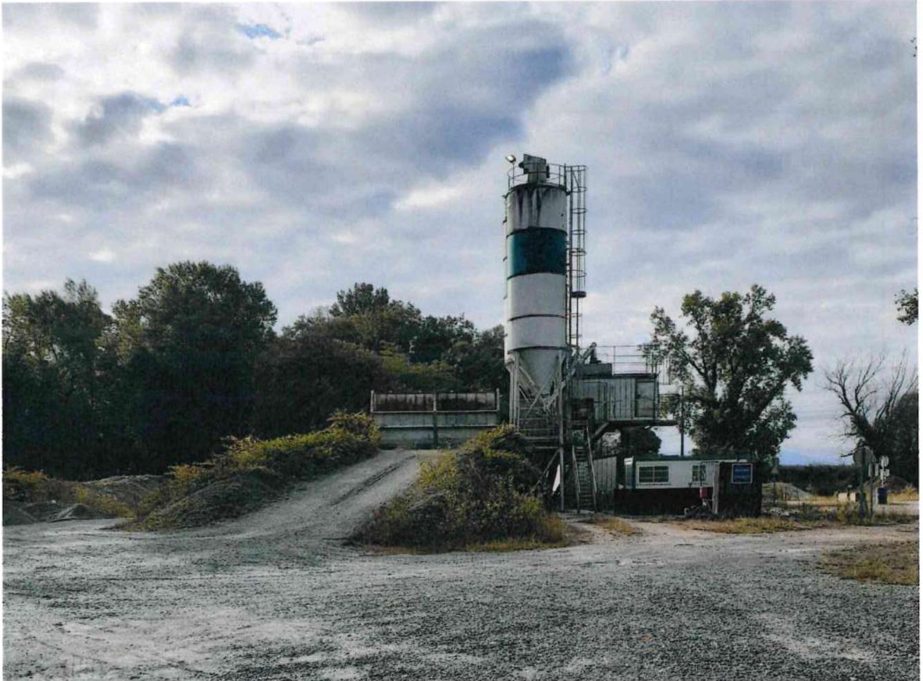
*Figure 16 : Photo de la centrale de fabrication de béton prêt à l'emploi*
