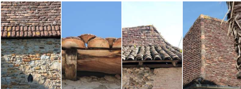
Faîtages et arêtières en tuiles rondes
