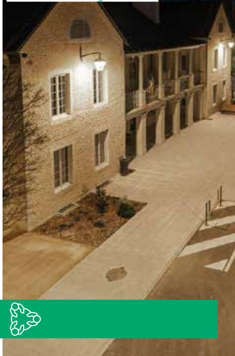
Eclairage public et valorisation patrimoniale du centre-bourg de Mont
