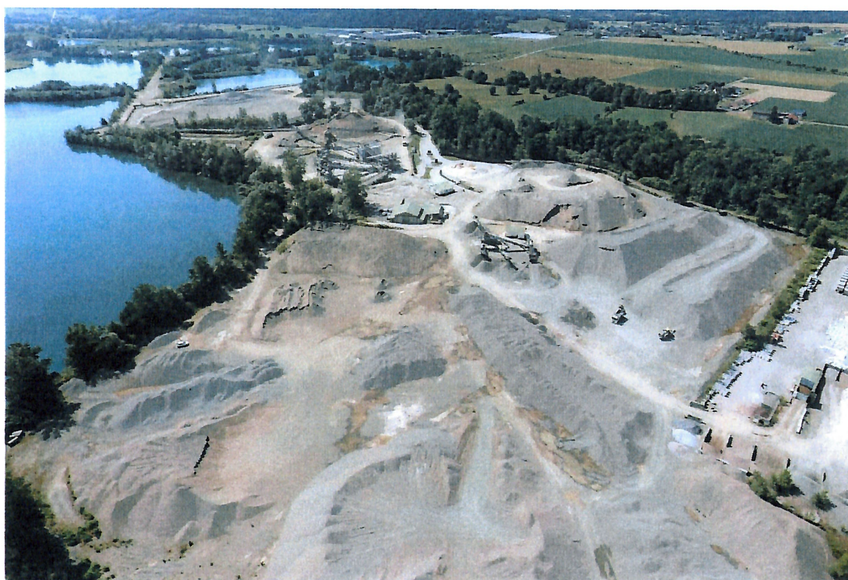
Figure 5 : Photographie de la zone de stockage des granulats d'Abos
