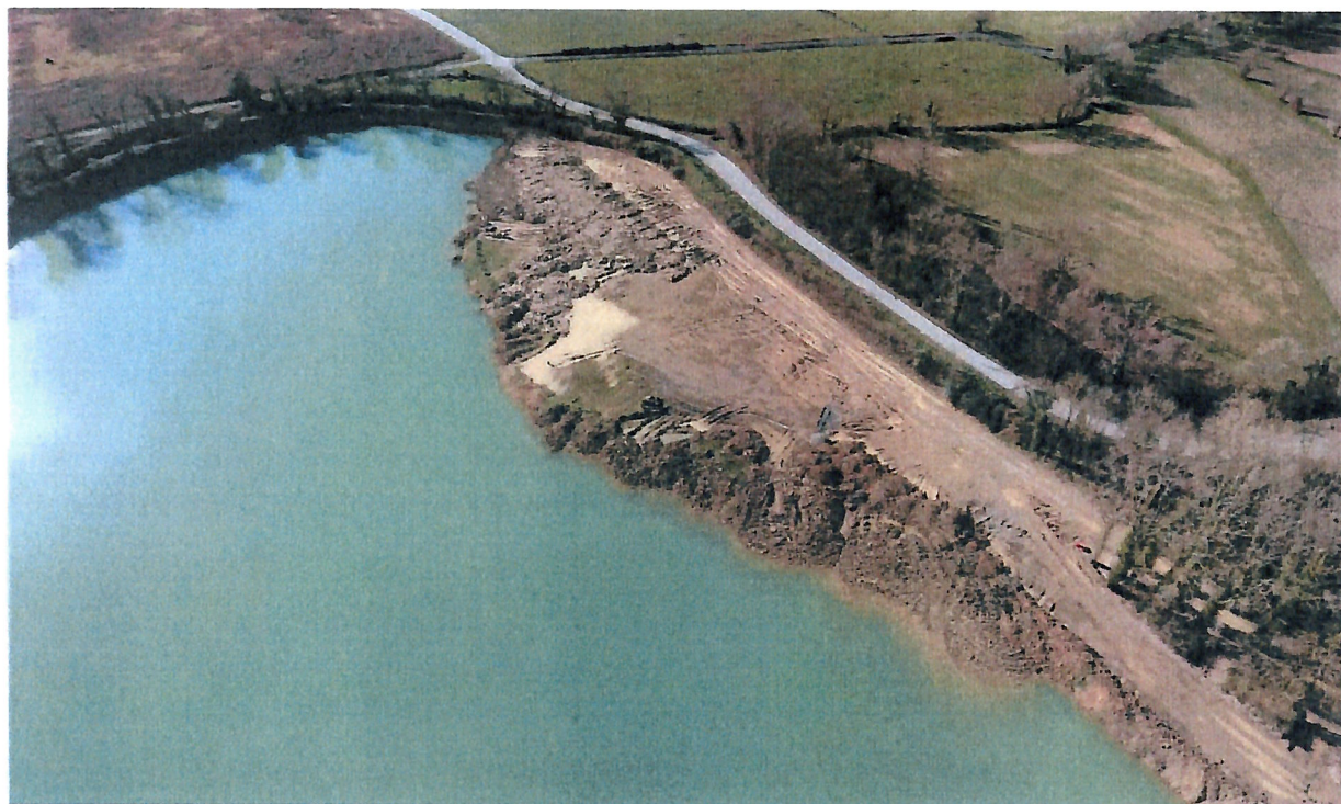
Figure 8 : Photographie d'un plan d'eau en cours de remblaiement pour son réaménagement à Abos
