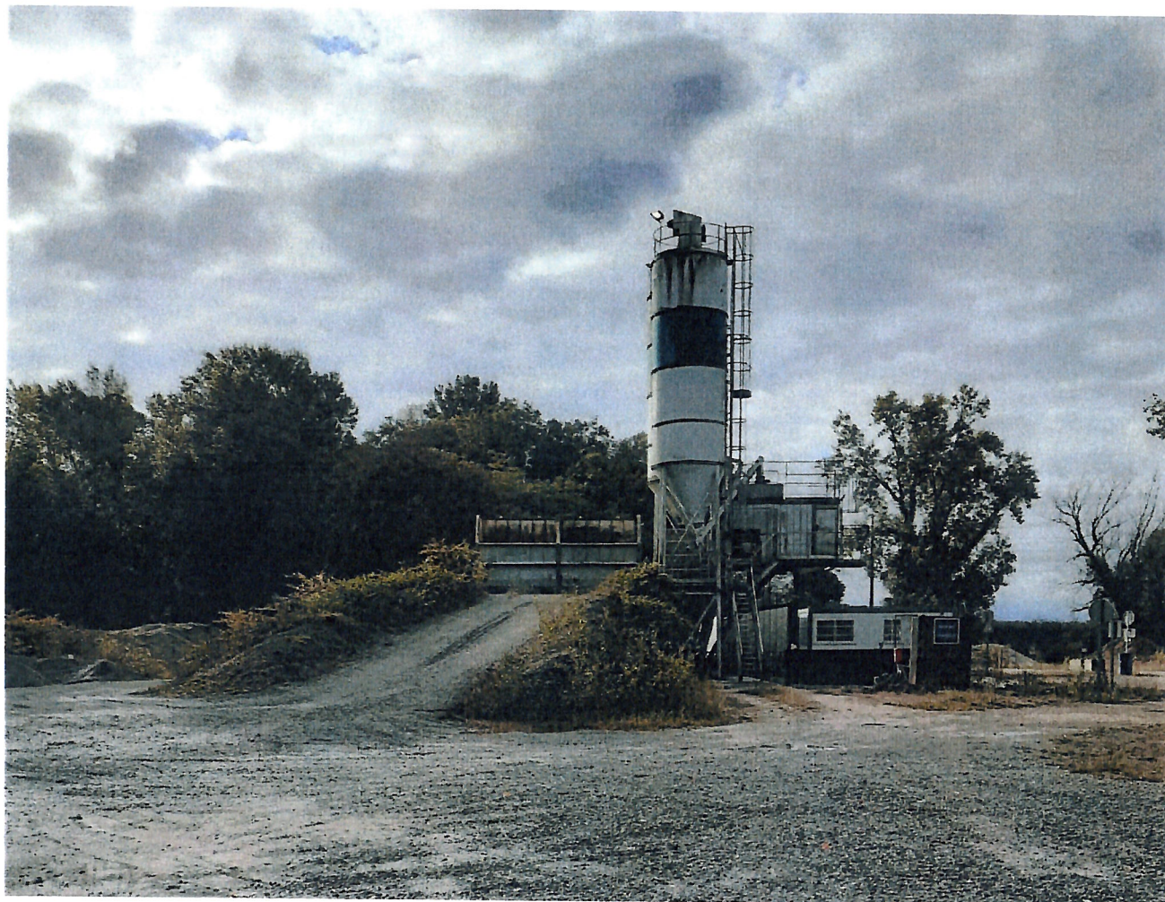
Figure 16 : Photo de la centrale de fabrication de béton prêt à l'emploi
