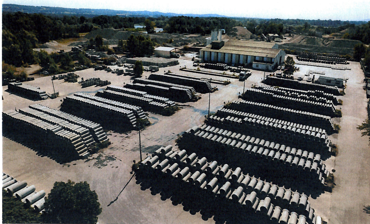
Figure 14 : Photo de l'usine de fabrication de buses en béton avec son parc de stockage
