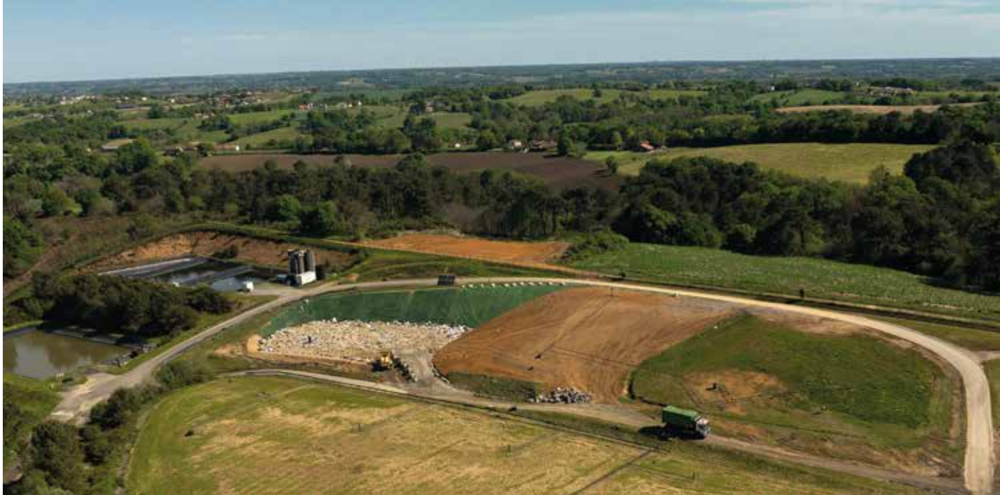
Notre installation de stockage de déchets non dangereux, à Orthez.
