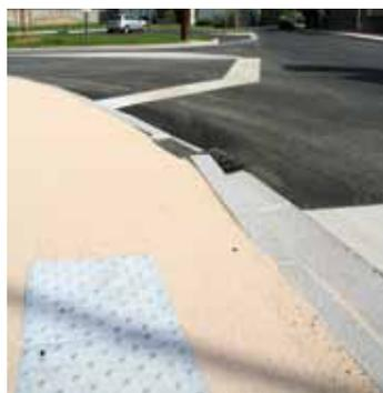
**BANDE D'ÉVEIL ET DE VIGILANCE** dite podotactile ; elle est placée sur un chemin piétonnier à 50 cm d'un obstacle et alerte d'un danger : escalier, voie circulée, etc.
