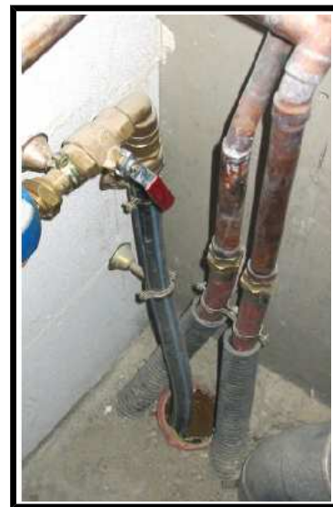
Calfeutrage des entrées de réseaux
