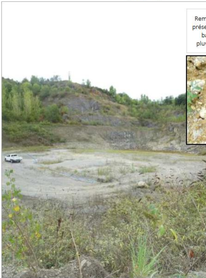
PL.7 : Photographie du fond de la fosse et des différents faciès du remblai (tout-venant de la carrière) Photographie du 13.09.2021
